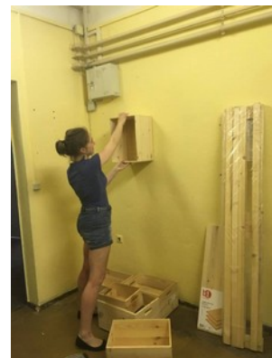
Bauarbeiten im Shop: Regalaufbau, Bohren der Löcher für die stabile Anbringung der Regale, Gestalten des Kisten-Regals
